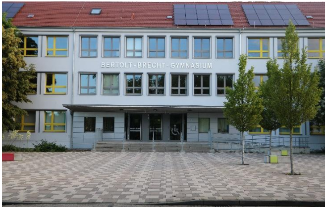
Hauptgebäude mit neuer Fassade sowie Wärme- und Sonnenschutz
