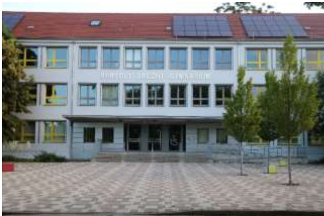
das „Brecht“ mit neuer Fassade sowie Wärme- und Sonnenschutz
